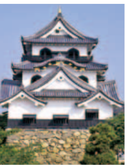
*1 박공(破風): 지붕의 끝에 있는 삼각형의 외벽 부분. 일본 건축의 기리즈마(切妻) 양식, 이리모야(入母屋) 양식은 지붕의 형태에 따라 기리즈마(切妻), 이리모야(入母屋), 가라(唐), 지도리(千鳥) 박공 등이 있다.
